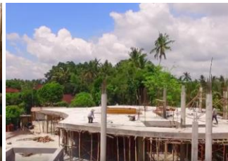
建設中の新クリニック
